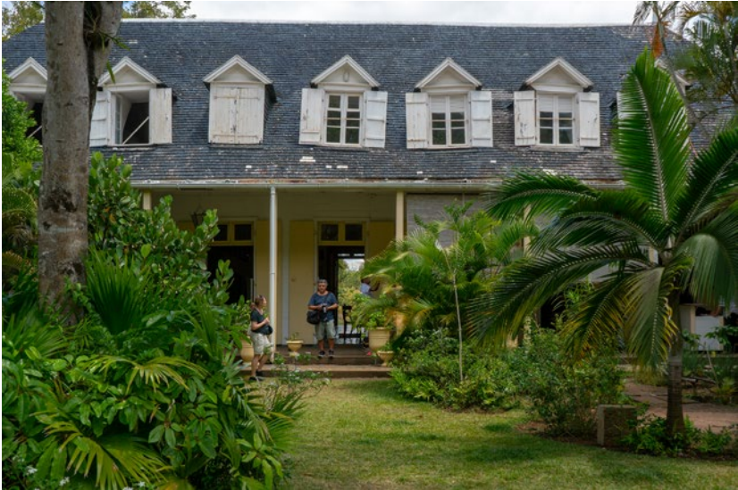
Das Haus aus dem frühen 19. Jahrhundert ist in einem erstaunlich guten Zustand.
