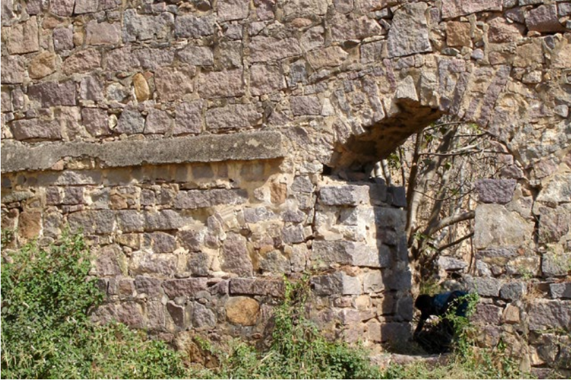
Das einzige noch erhaltene Tor der alten Burg führt nach Süden, in Richtung Fluss.
