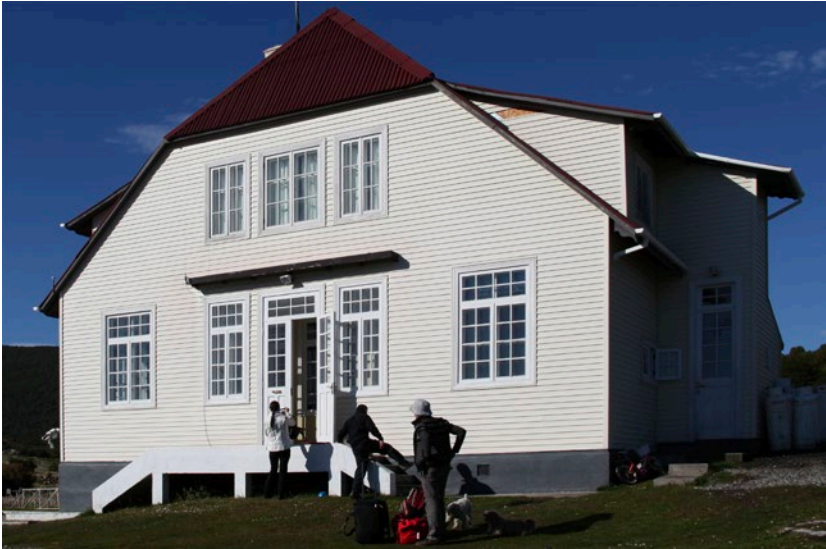
Das Gemeindehaus wurde um 1940 zum größten Teil aus Holz errichtet und gehört zu den größeren Gebäuden von Carbelotte. Es wurde 2012 sorgfältig restauriert.
