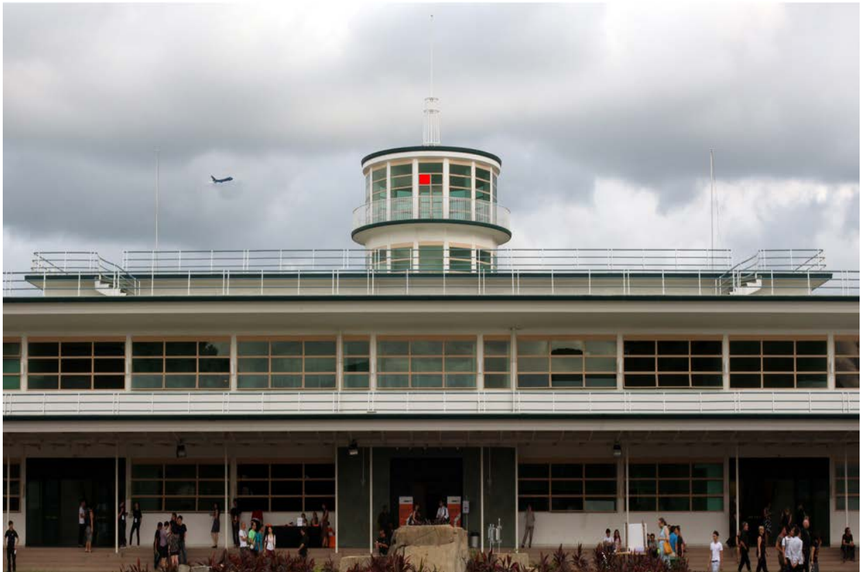
Das Flughafengebäude des Airport Oscar I. wurde vor 1933 als Villa erbaut und 1973 umgewandelt.
